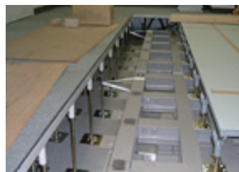
ゾーン免震タイプ設置後
